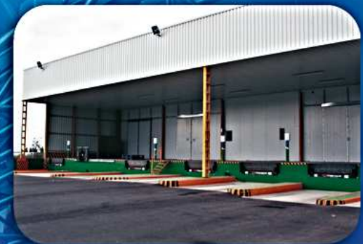
Quai de chargement et déchargement
